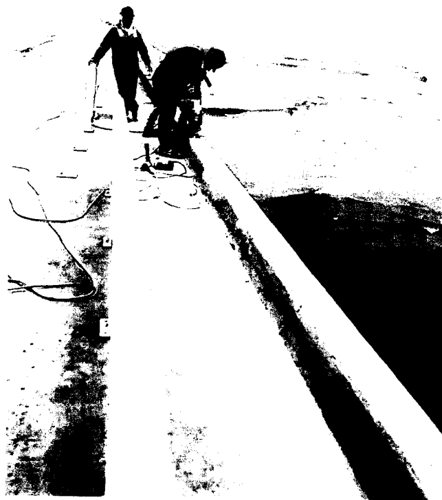
FOTO 12: Entubado y encofrado de sardinel del día 17/07/19
