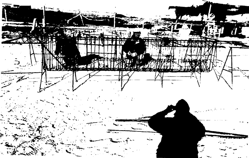
FOTO 16: Armado de viga de guardia del cabezo
