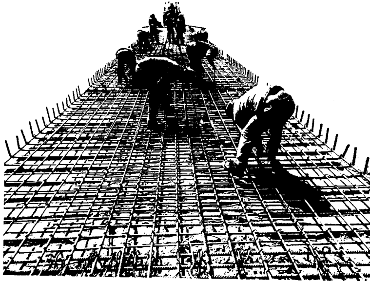
FOTO 01: Armado de acero en losa del día 01/07/19
