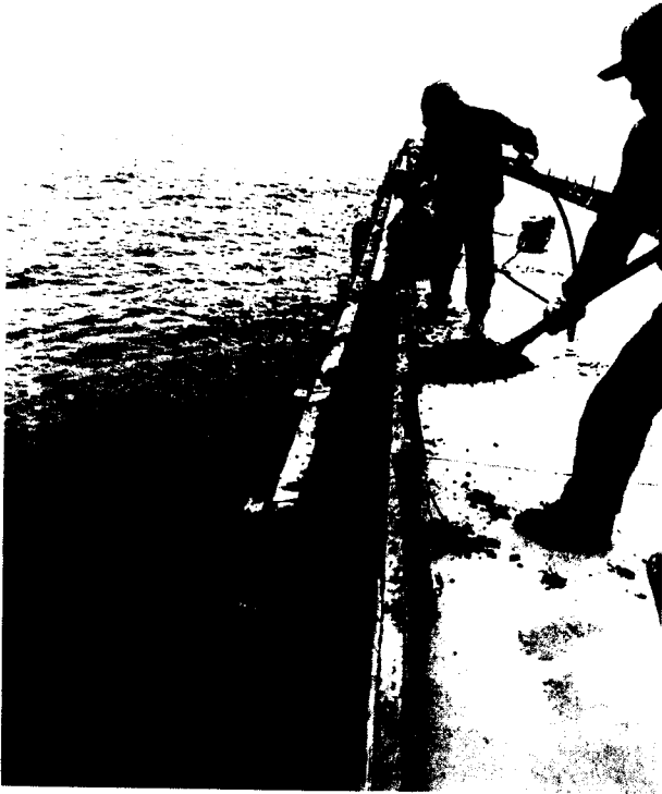
FOTO 13: Se continúa con el encofrado de sardineles
