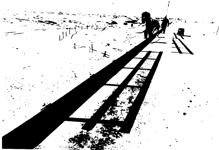
FOTO 11: Instalación de barandas en el sardinel del muelle San José
